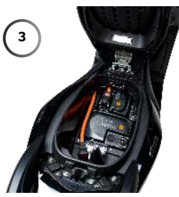
Débranchez la ou les batteries,
